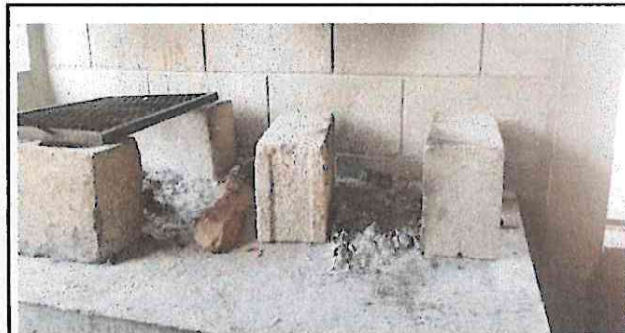
Foto 6: INSTALACIÓN DE AZULEJO EN ESTUFA RURAL Y MUEBLES. LA COCINA CARECE DE AZULEJOS
