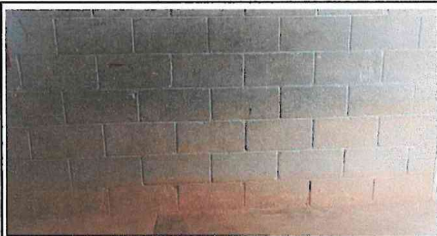
Foto 3: PINTURA EN MUROS EXTERIORES E INTERIORES
